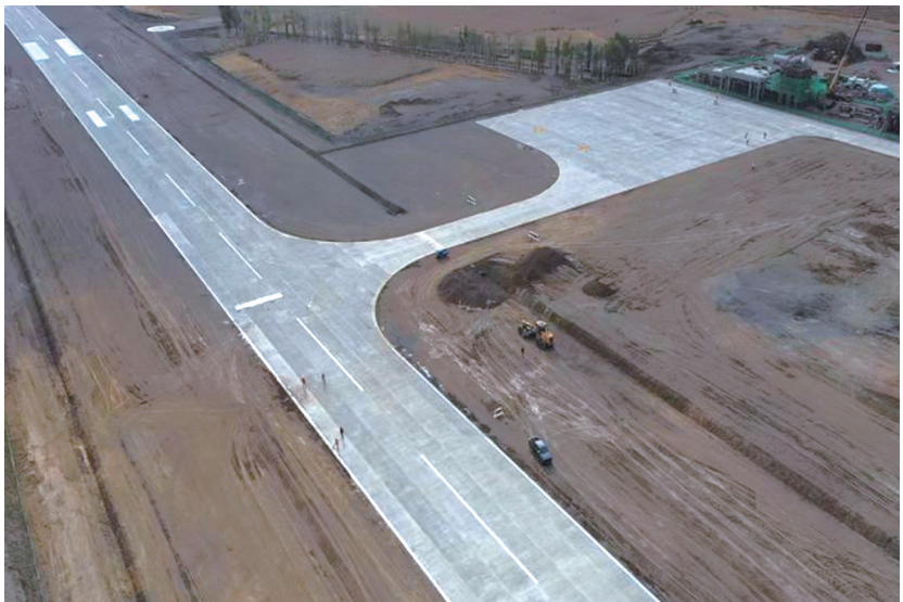
突泉县通用机场项目施工现场
