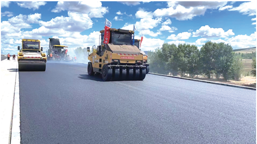
G5511草高吐至乌兰浩特公路项目施工现场
