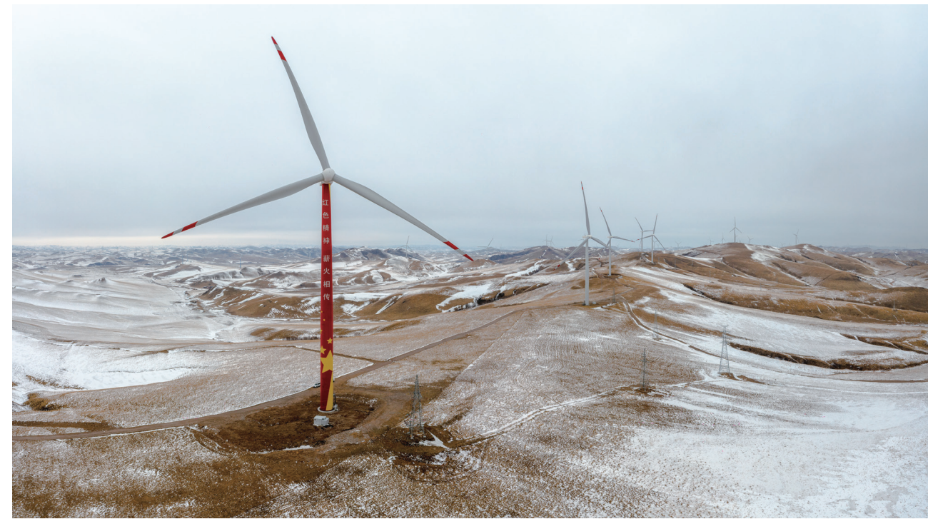
位于科右前旗桃合木苏木的中广核兴安盟300万千瓦风电项目 记者 包宝音德力格尔 摄
